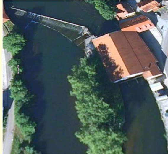
Zustand vor dem Umbau
